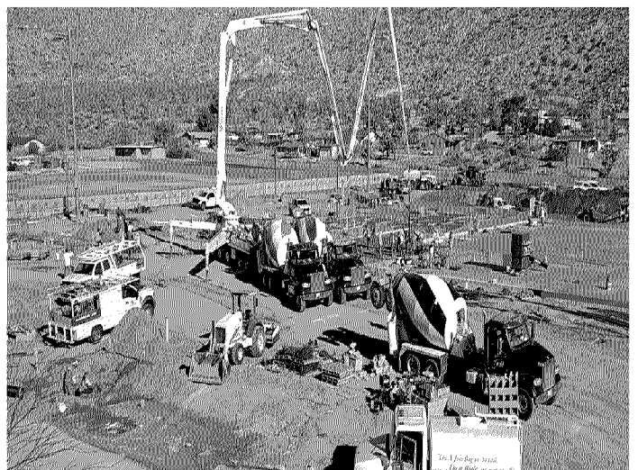
Section 'B' Slab-On-Grade Pour
