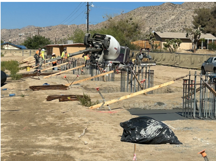
Concrete Pour Solar Canopy Footings
